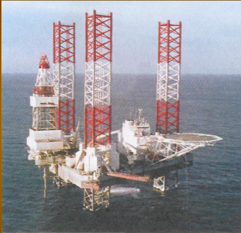
ПЛАВУЧАЯ БУРИЛЬНАЯ УСТАНОВКА НА ШЕЛЬФЕ ОХОТСКОГО МОРЯ
